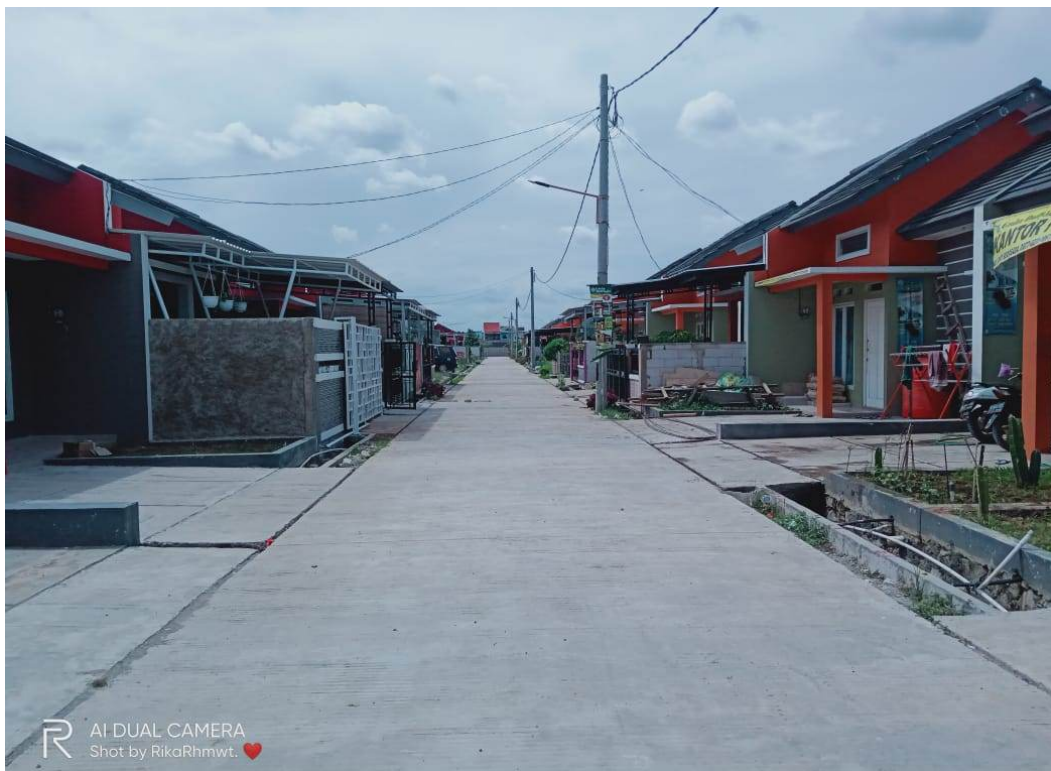
TAMPAK SAMPING PERUMAHAN GRAHA DAFFYLAGIO
